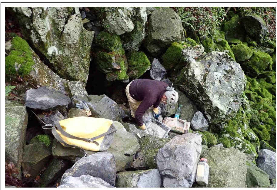
◁ Travaux de maçonnerie pour tenter de consolider l'éboulis dans lequel s'ouvre l'entrée du Río Sordo (n°354)
